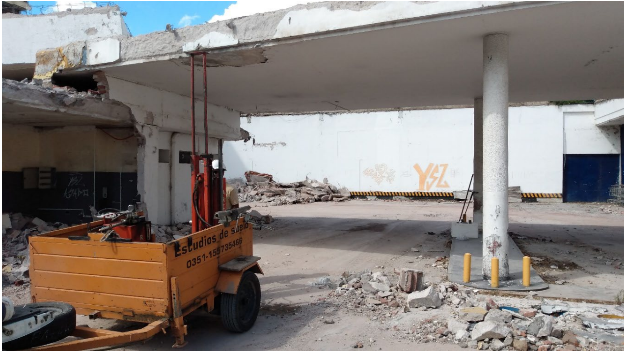
Foto N° 6: Ejecución del sondeo S5
