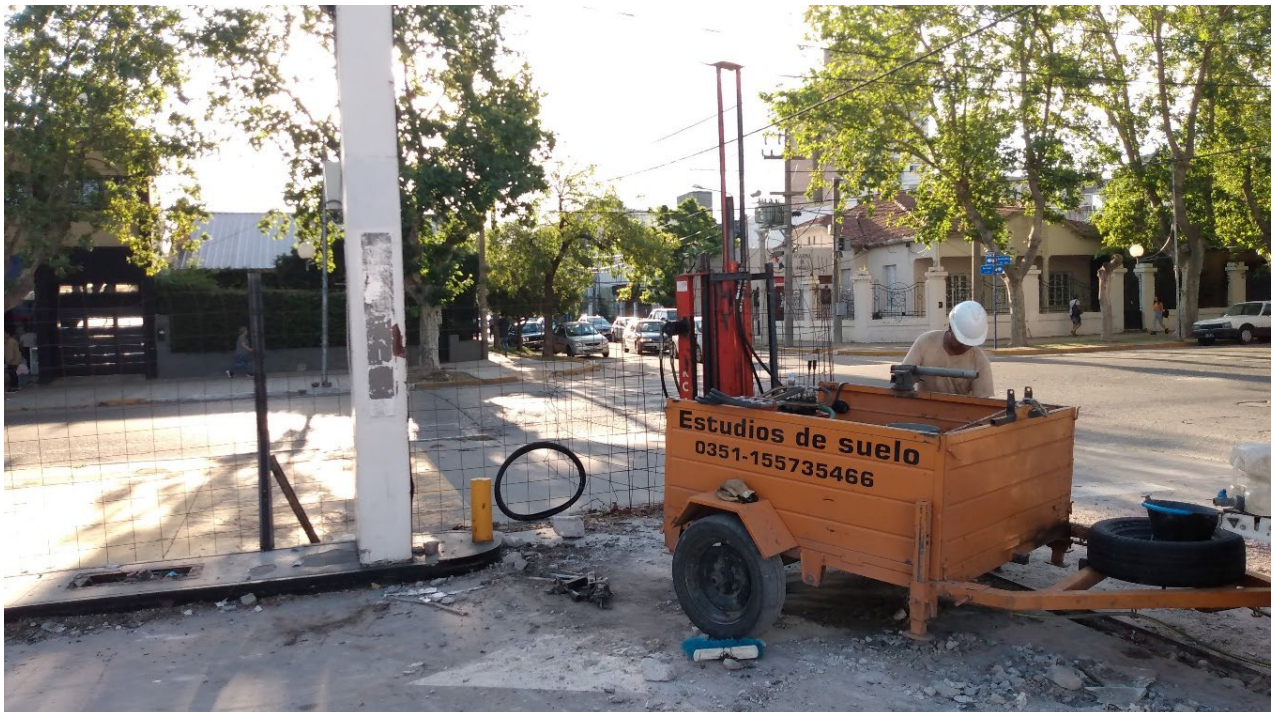
Foto N° 3: Ejecución del Sondeo S3
