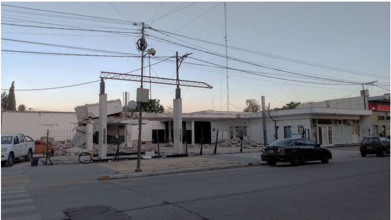
Foto N° 1: Vista general del sitio en proceso de demolición.
