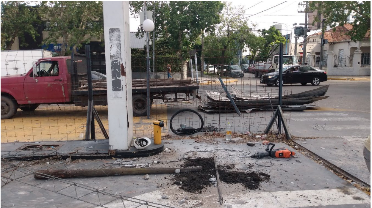
Foto N° 2: Apertura del sondeo S3.
