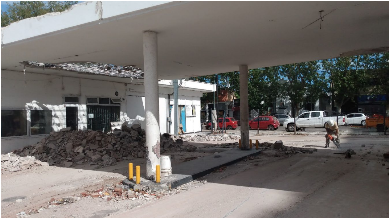
Foto N° 5: Apertura del sondeo S5
